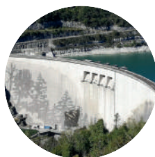
LIEU À VISITER 8 CERNON Barrage de Vouglans
