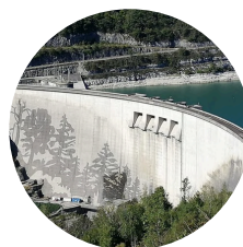
LIEU À VISITER 8 CERNON Barrage de Vouglans
