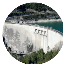
LIEU À VISITER 8 CERNON Barrage de Vouglans
