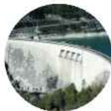
LIEU À VISITER 8 CERNON Barrage de Vouglans
