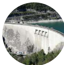
LIEU À VISITER 8 CERNON Barrage de Vouglans
