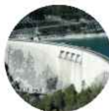
LIEU À VISITER 8 CERNON Barrage de Vouglans
