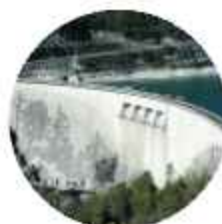
LIEU À VISITER 8 CERNON Barrage de Vouglans
