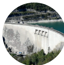
LIEU À VISITER 8 CERNON Barrage de Vouglans
