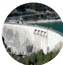
LIEU À VISITER 8 CERNON Barrage de Vouglans
